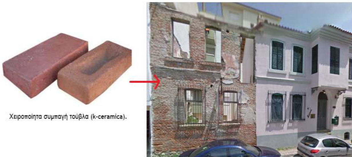
(8) (Εικ. 4: Συμπαγείς οπτόπλινθοι (k-ceramica) και κέλυφος από φέρουσα τοιχοποιία (Αρχείο συγγρ))
